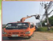
กองช่าง ลงพื้นที่ดำเนินการซ่อม...
